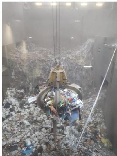
**Figura 07:** Guindaste rolante em operação no fosso de armazenagem dos resíduos.
